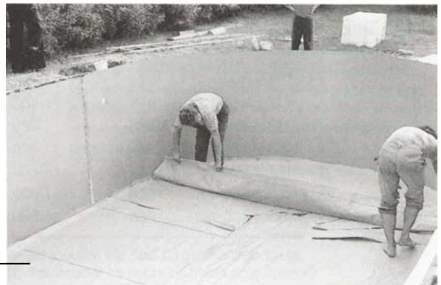
Raum für Magerbeton- Hinterfüllung
